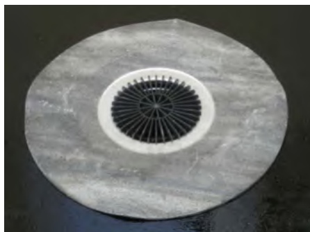
2. Закрепить корпус воронки HL62H
