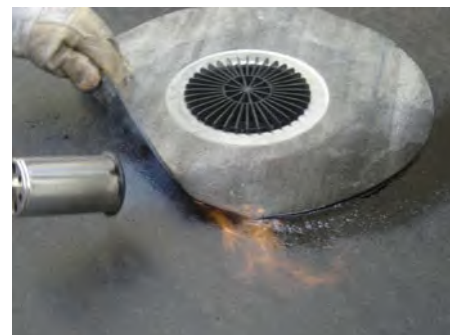
3. Приварить полимербитумное полотно воронки
