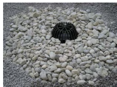
12. Засыпать гравием остальную поверхность кровли
