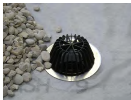
11. Установить листоуловитель, выполнить засыпку гравием (фракция: 20÷40 мм)
