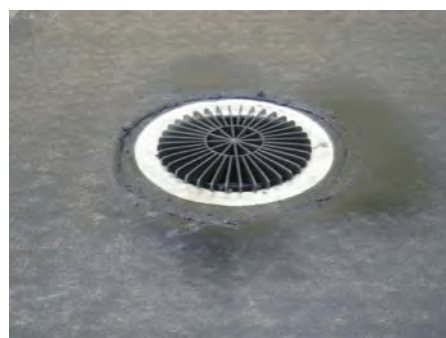
5. Так должна выглядеть воронка после укладки гидроизоляции
