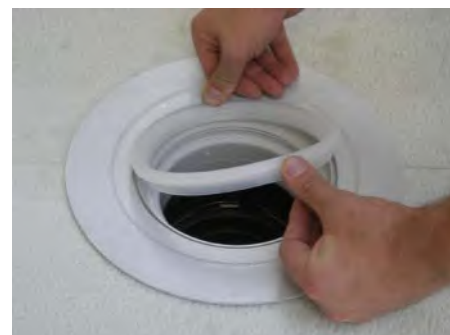
9. Убедиться в правильности установки прозрачного пластикового кольца
