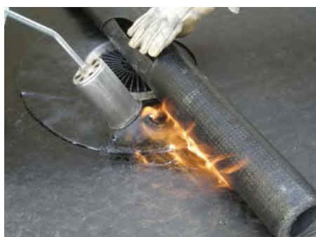
4. Наклеить 2-й слой гидроизоляции (до обжимного фланца)
