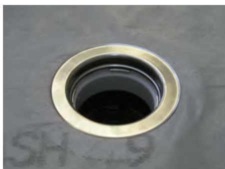
10. Зажать фильтрующий слой фиксирующим фланцем элемента HL350.0
